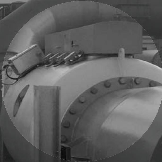
Entkopplung einer Rohrleitung mit EXKOP® QV II.
